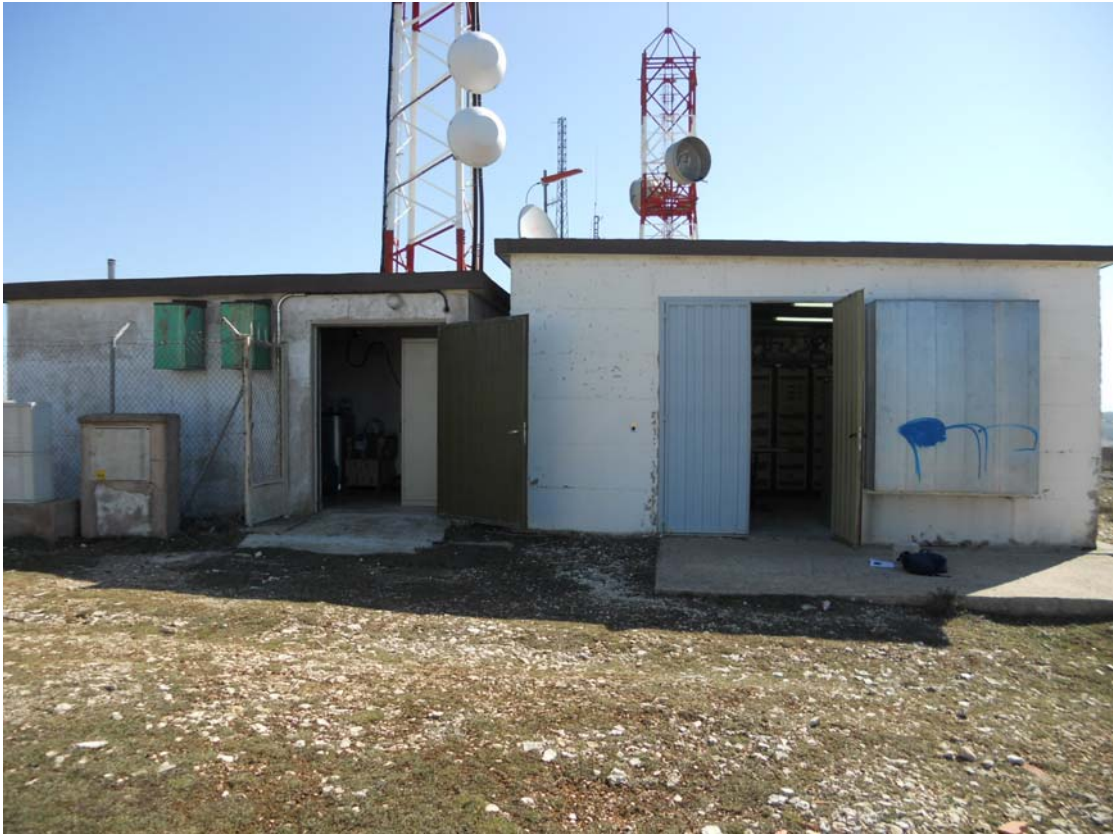
Caseta donde se ubican equipos telecomunicaciones
