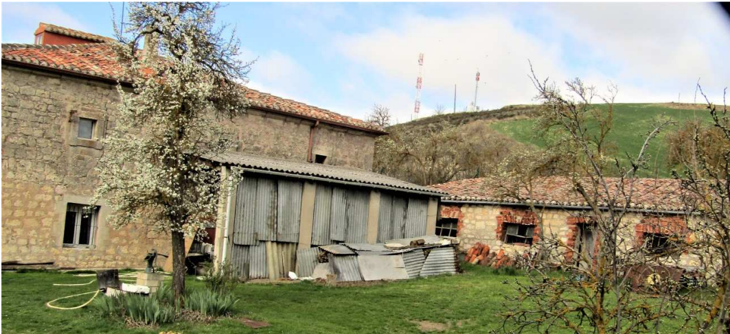
Fachada Este y cobertizos anexos
