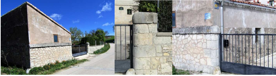
Vallado existente Camino Santiago y detalles mochetas puerta entrada
