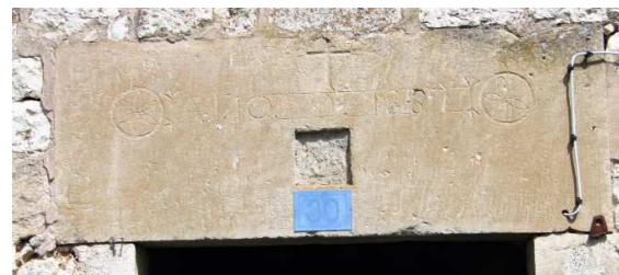
Cargadero puerta principal
