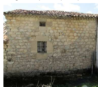
Fachada trasera vivienda. Ventana
